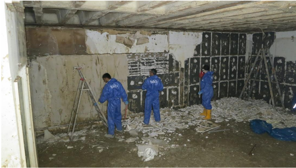
Abbildung 18: Sanierungsarbeiten an einem Gebäude in Künzelsau. Aufgrund der Feuchteschände ist in vielen Fällen ein Rückbau der Keller- und Erdgeschosse in den Rohbauzustand erforderlich.
