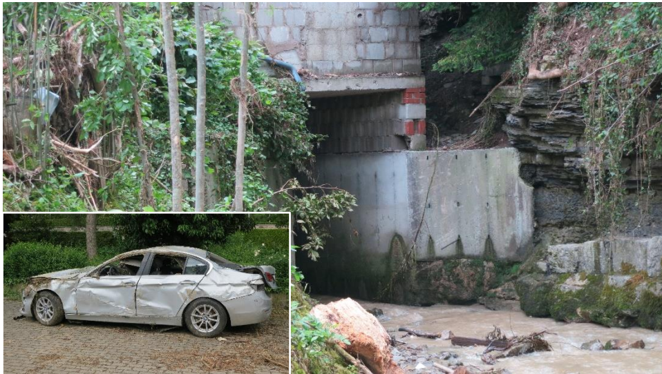
Abbildung 17: Einlass zur Unterführung eines Gebäudes, der beim Hochwasser durch ein querstehendes KFZ verlegt wurde.
